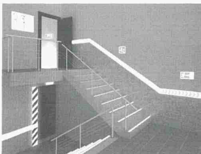
Фотолюминесцентная эвакуационная система (ФЭС) (свещающиеся в темноте полосы и знаки)
